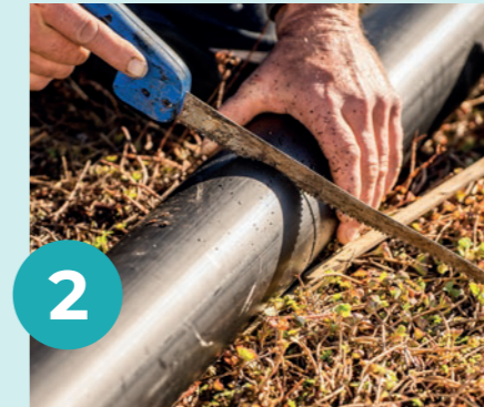
2 Rohr und Sensor an Höhe des Dachaufbaus anpassen.
