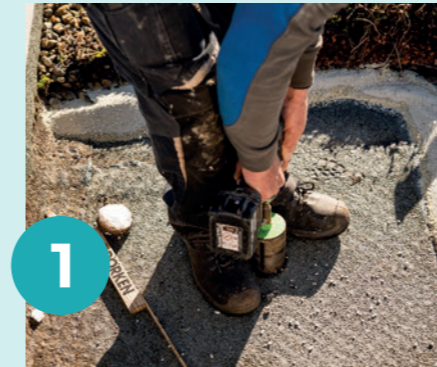
1 Montageöffnung vorbereiten. Kronenbohrer 82 mm verwenden (Dampfsperre nicht verletzen).
