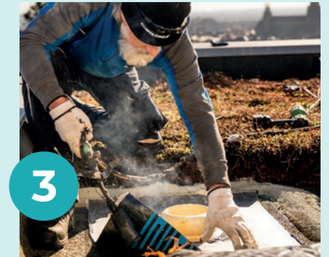
3 Einbau-Kit mit passender Anschlussmanschette in Dachabdichtung einbinden.
