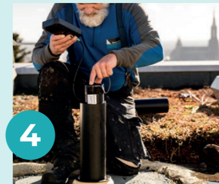
4 Sensor in Rohr einsetzen (Sensorenplatte muss auf Dampfsperre aufsitzen).
